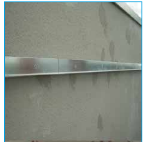
2- Procedere col fissaggio delle staffe di sostegno alla parete mediante tasselli tipo fisher in caso di profili particolarmente grandi.
