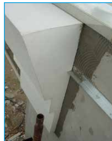
Cornicione realizzato su richiesta del cliente
