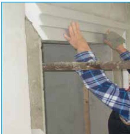
3 - Verificare misure ed effettuare taglio
