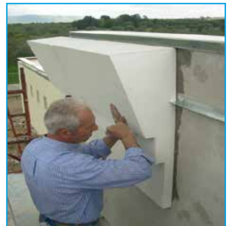
5 - Montaggio del profilo rivestito.Per la corretta posa di un cornicione decorato, si consiglia di eseguire il montaggio partendo dagli angoli dell'edificio.
