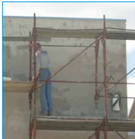
1 - Rendere il fondo : piatto, asciutto, pulito, stabile nonchè libero da sostanze antiaderenti (polvere, muschio, piante...)Livellare eventuali parti della precedente intonacatura e lisciare il fondo.
